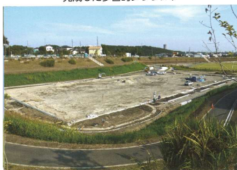
工事中のテニスコート
