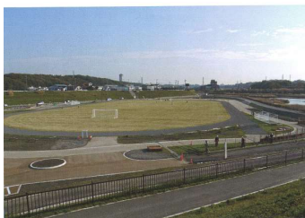
完成した多目的グラウンド
